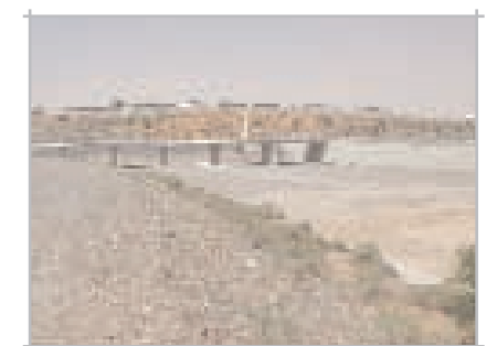
Shwaib Wadi Diversion Channel
